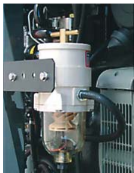
Дополнительный топливный фильтр с влагоотделителем
